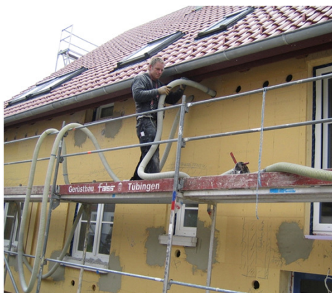
Zellulose Einblasdämmung für Dach und Wand
